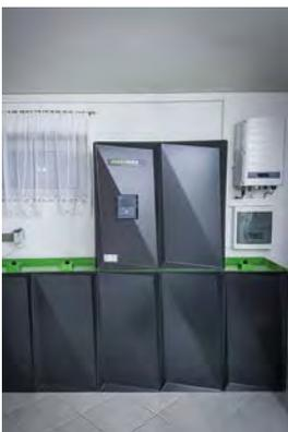
Ziel: Jährlichen Stromverbrauch von ca. 5000 kWh möglichst durch eigene **Solarenergie** abdecken. Installation von 10 kWp Solaranlage und 10 kWh Stromspeicher. **Sicherheit und Umwelt** stehen im Fokus. Keine gefährlichen oder begrenzten Rohstoffe werden zur Energiespeicherung verwendet.
